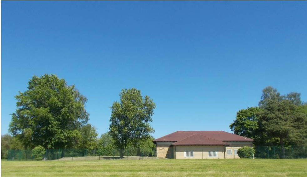
Abb.2: Südlicher Bereich des bestehenden Pumpwerks mit Gehölzen
